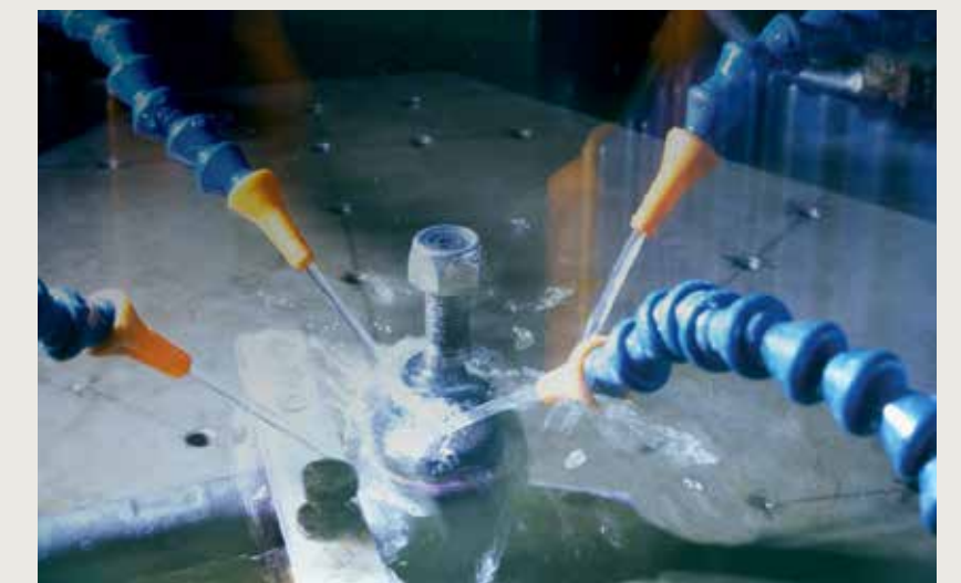
Pruebas de infiltración de agua
